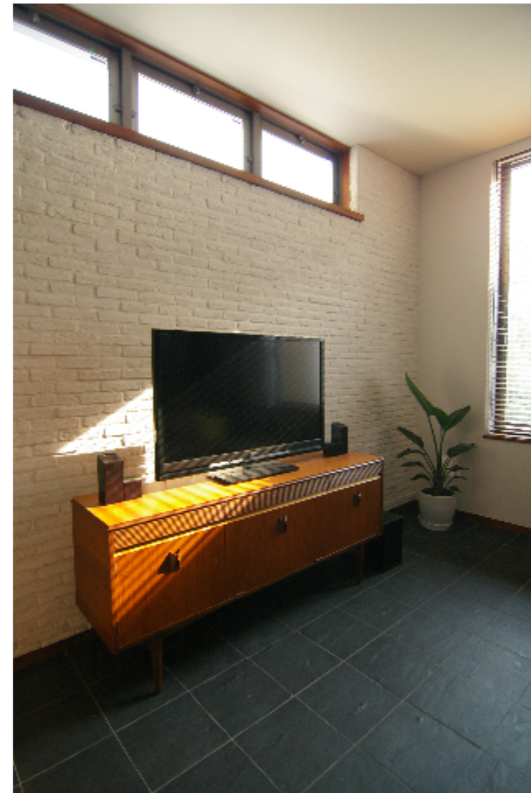
玄昌石の敷き詰められた蓄熱式の土間リビング。冬はほんのり夏ひんやりと気持ちが良い。
